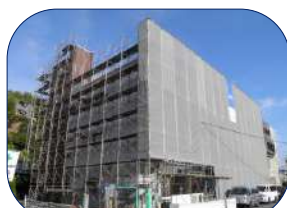
◆耐震・修繕工事中の貨物会館
