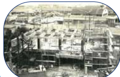
◆建設途中の貨物会館全景
